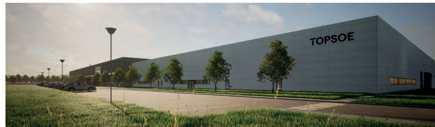
Figur 19: Visualisering af Topsoes SOEC-produktionsfabrik, der er designet til årligt at producere SOEC svarende til 500 MW elektrolyse fra forventeligt 2025 med muligheder for at udvide til 5 GW.
