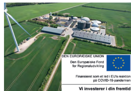
Figur 20: Billede af GrønGas' anlæg ved Hjørring.
