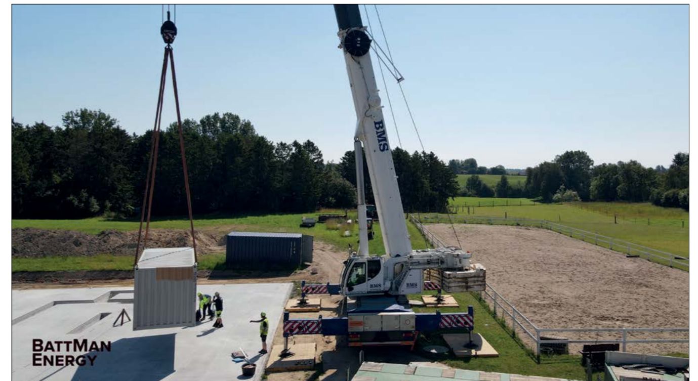
Billeder fra etableringen af BattMan Energys første batteripark nær Ølstykke. Parken har en effekt på 9,25MW og består af containeriserede batterianlæg (BESS).
