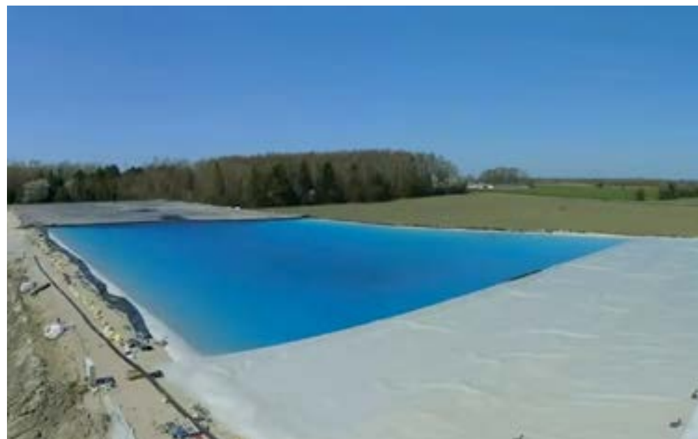
Damvarmelager på 70.000 m³ i Høje Taastrup under etableringsfasen.
